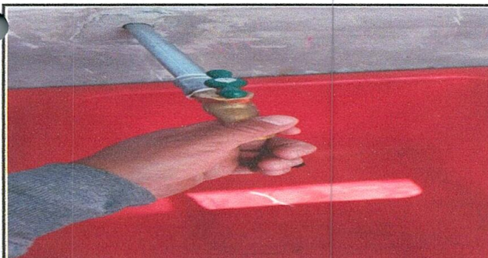
Foto 5: Sustitución de grifo
