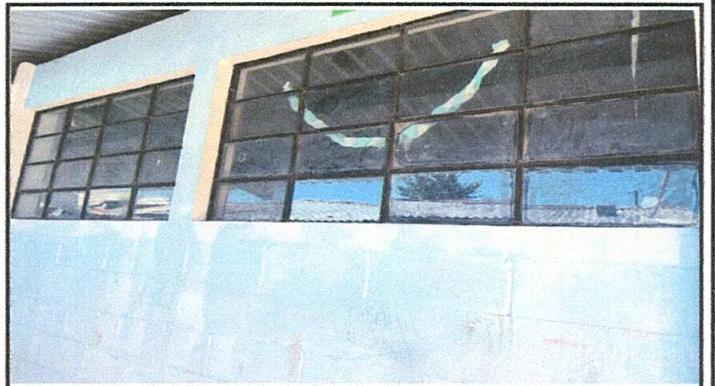
Foto 4: Sustitución de Vidrios
