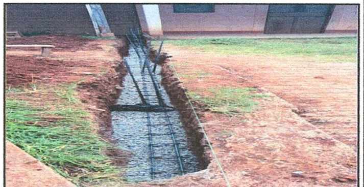
Foto 6: Reparación de muro perimetral de block con tubo y malla galvanizada
