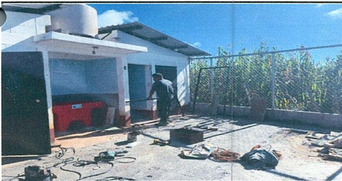
Foto 5: Sustitución de puerta en servicios sanitarios
